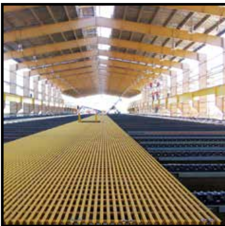
Instalación en mina de cobre
