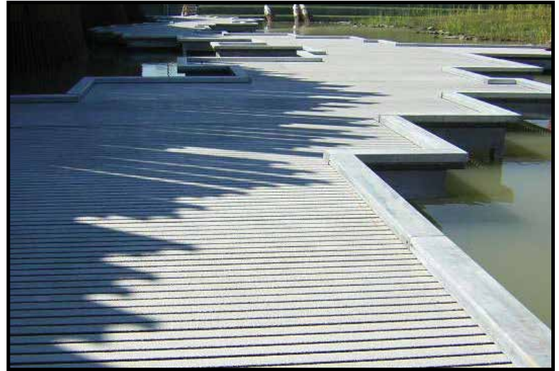
Muelle del pontón en Portland, Oregon.
